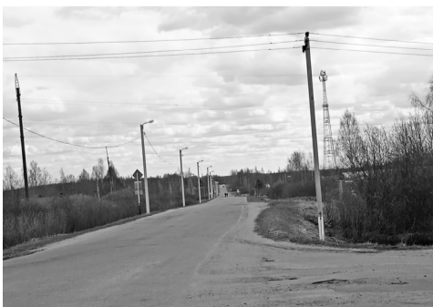
Одна из новых линий электропередач в селе Глинка.
