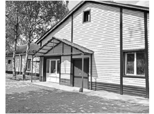
Здание реконструированной общественной бани в селе Глинка.
