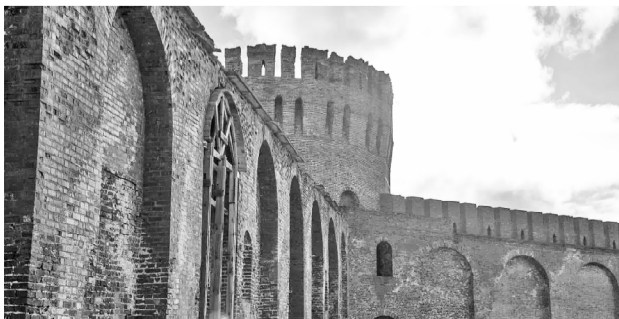
Ремонт крепостной стены продолжится.
